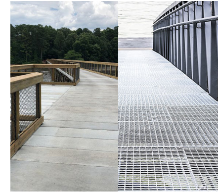
Sendero elevado (concreto, metal)
