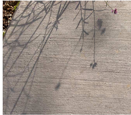
Pavimento -convencional (gris con acabado en la superficie)
