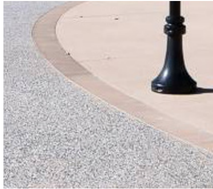
Pavimento -mejorado (con acabado y color)
