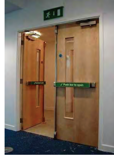
3 FIRE DOOR SEPARATION EXAMPLE N.T.S.
